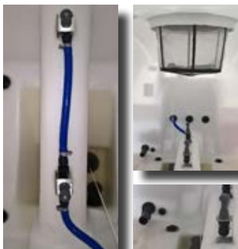
Venturi d'agitation et lav'tons de fond de cuve Tamis trou d'homme
